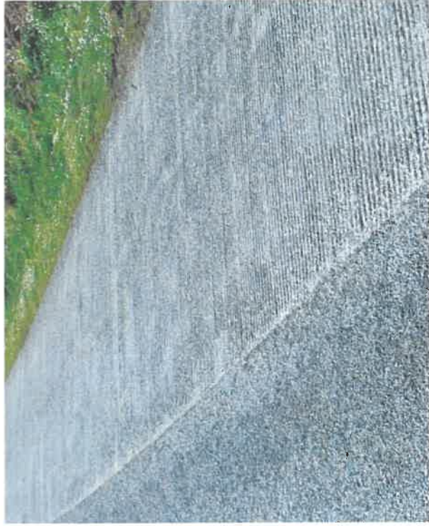
Rampe béton (Molène)
